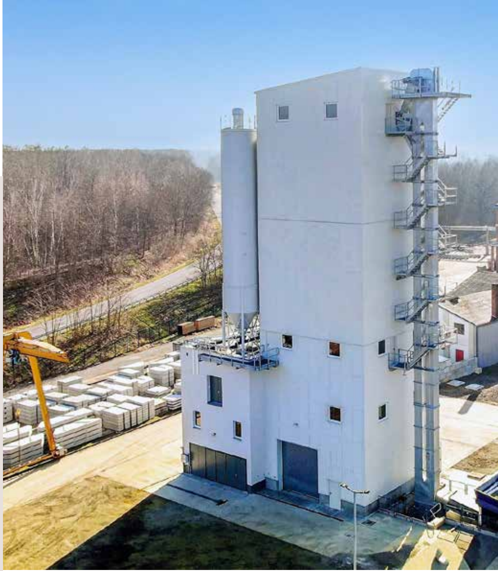
Anlage mit kompletter Eirich-Masseaufbereitung
