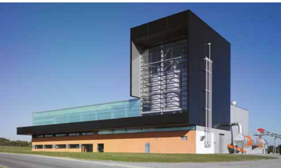
Bâtiment de l'usine Élévateur vertical au-dessus du mélangeur Mélangeur intensif EIRICH RV19 Sortie du produit fini avec ensacheuse
